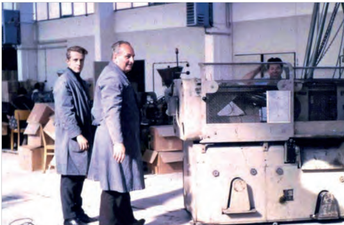
Die Maschinen werden im Neubau aufgestellt.
